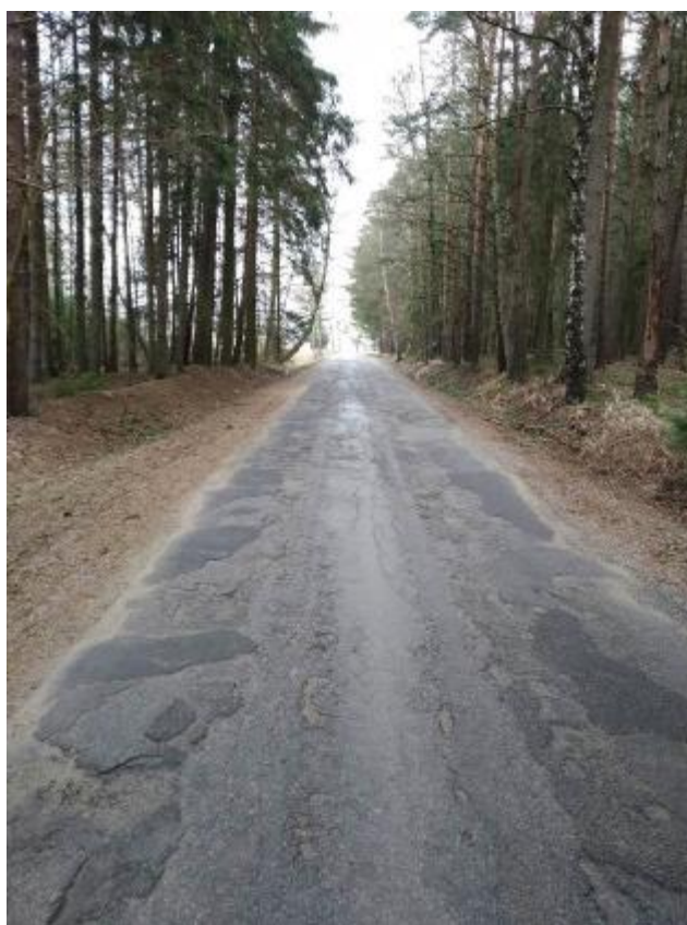
pohled po směru staničení, značně porušené vozovka
