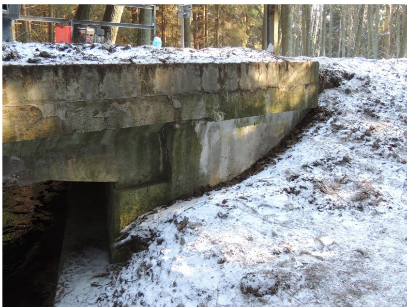
Křídlo pravobřežní opěry na nátokové straně
