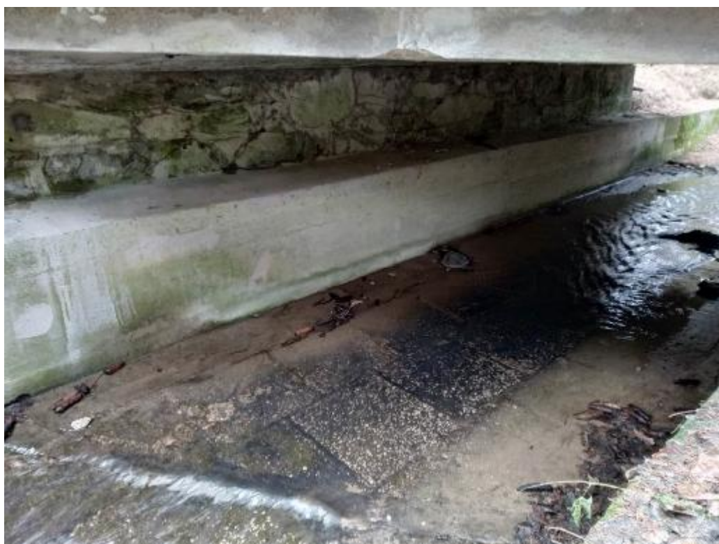
pohled pod most, zpevněné dno a ochranné prahy v patě opěry
