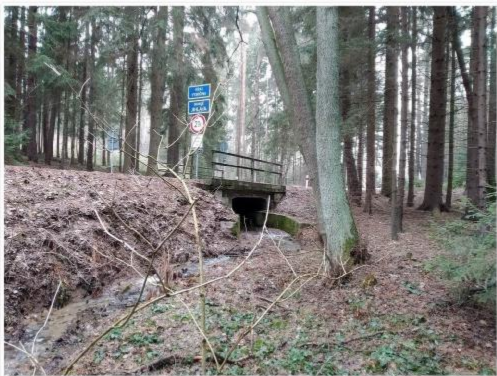
podemleté těleso komunikace vpravo před mostem (výtok)
