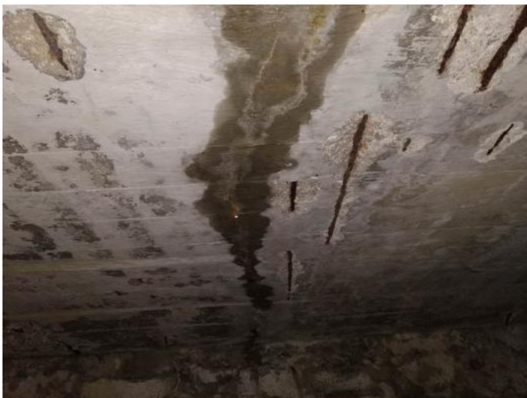
průsaky na dolním líci NK, přibližně uprostřed mostu
