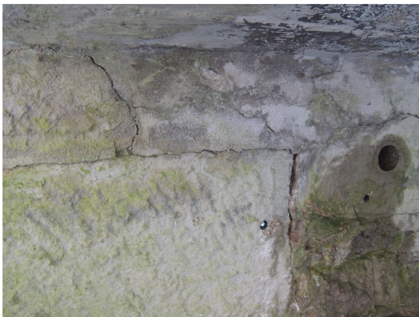
Popraskaný kamenný kvádr v místě odběru vzorku B – pravá opěra na odtokové straně
