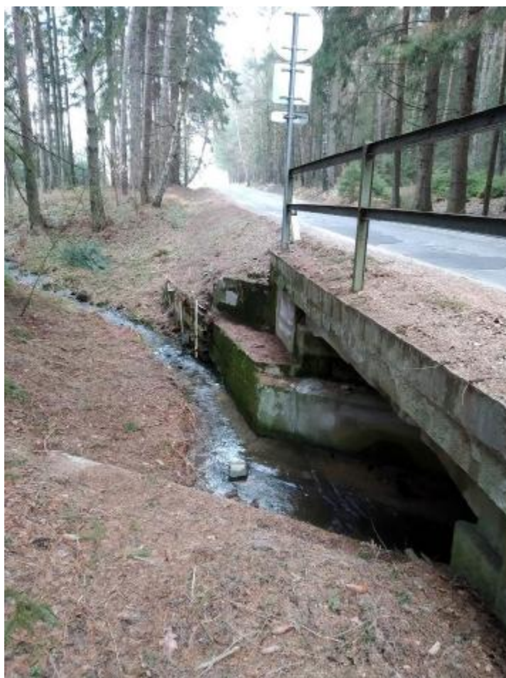
podemleté těleso komunikace vlevo za mostem s provizorním zajištěním v patě (nátok)
