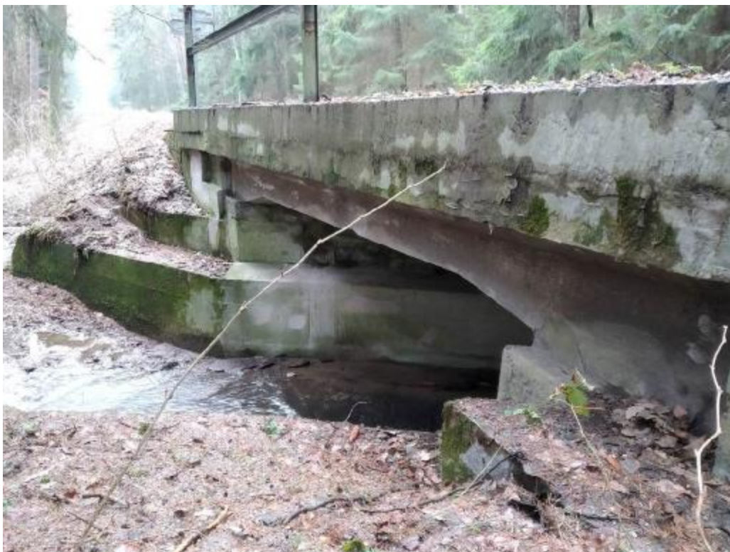
pohled na výtokovou část mostu, degradace betonů
