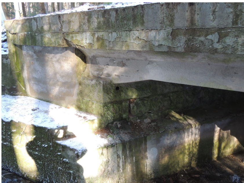
Místo odběru vzorku A z kamenného zdiva levé opěry
