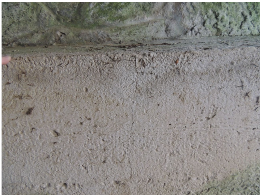
Smršťovací trhлина na betonovém prahu pravé opěře
