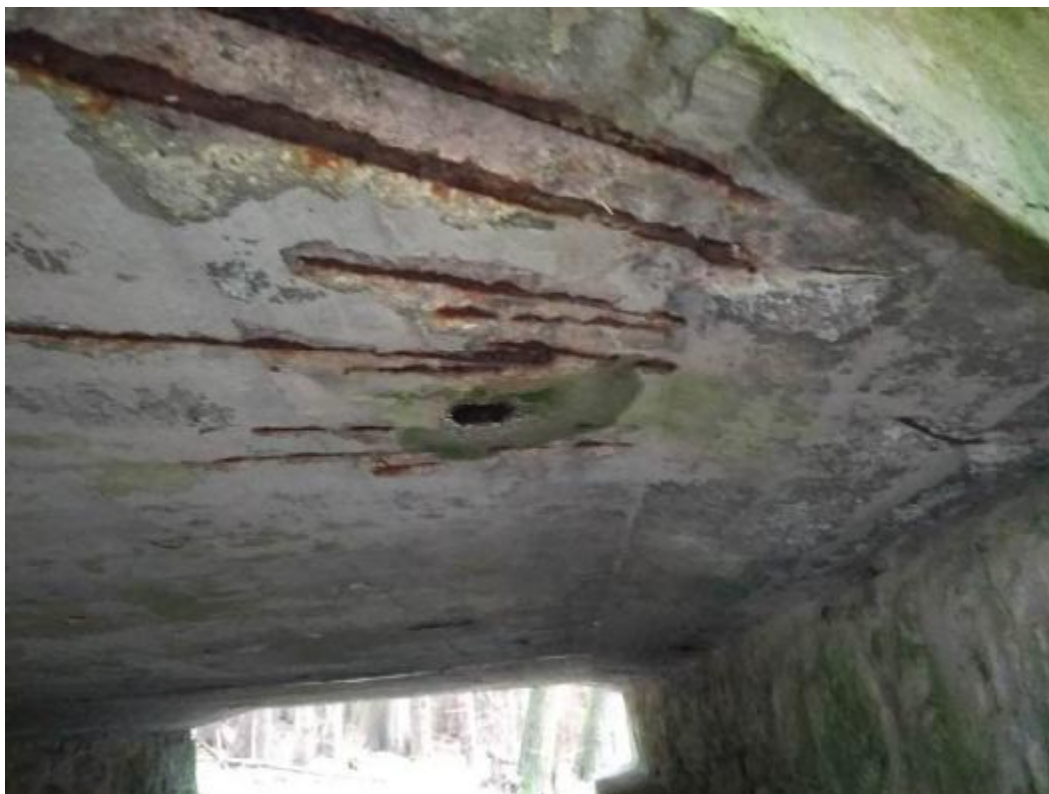
pohled na dolní líc NK, odhalená a zkorodovaná výztuž, degradace betonu
