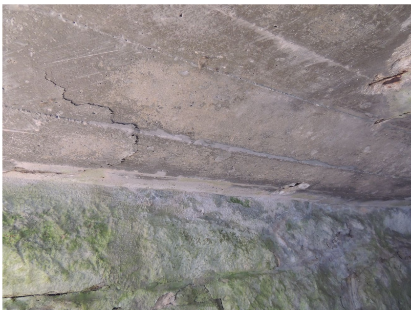
Trhliny v podhledu desky od korodující výztuže
