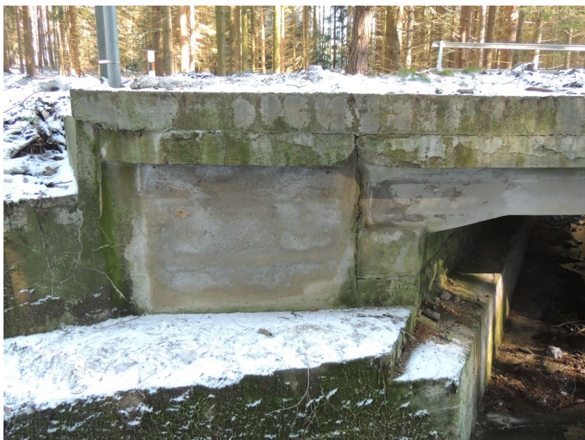
Křídlo levobřežní opěry na nátokové straně
